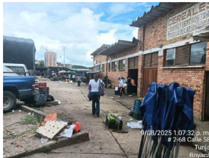
Ilustración 3. Manejo inadecuado de basuras
