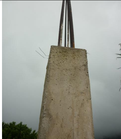
Oxidación en acero de alfajías y columnas, que se encuentran a la intemperie
