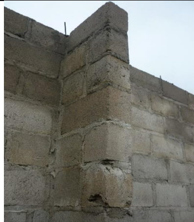
Oxidación en acero de alfajías y columnas, que se encuentran a la intemperie
