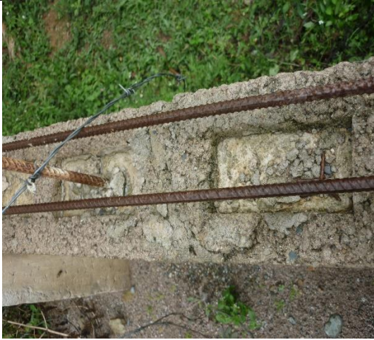
Oxidación en acero de alfajías y columnas, que se encuentran a la intemperie
