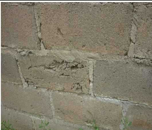
disgregación en zonas del muro en bloque
