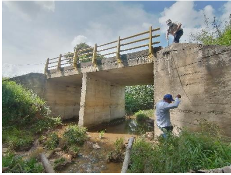
Vista general estructura.
